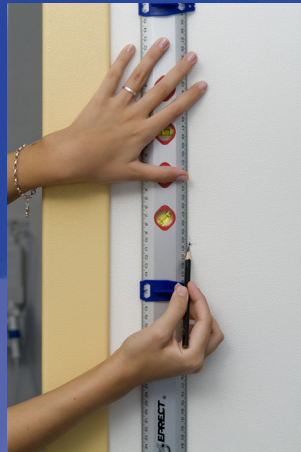
Anreißen - ein Bohrloch ist ausreichend
