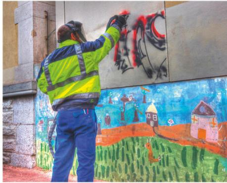
Extrem langlebige einkomponentige Beschichtung ohne Opferschicht (= Schicht, die zum Schutz des darunterliegenden Materials aufgebracht wird und nach der Reinigung neu aufgebracht werden muss) und mit hervorragend schützenden Eigenschaften vor Graffiti Verschmutzungen. Einfaches Entfernen von Graffiti nur mit Wasser oder sanften Reinigungsmitteln (z.B. dem CCM-Bioreiniger **Biosativa®**). Hält dutzenden Graffiti Angriffen stand.
